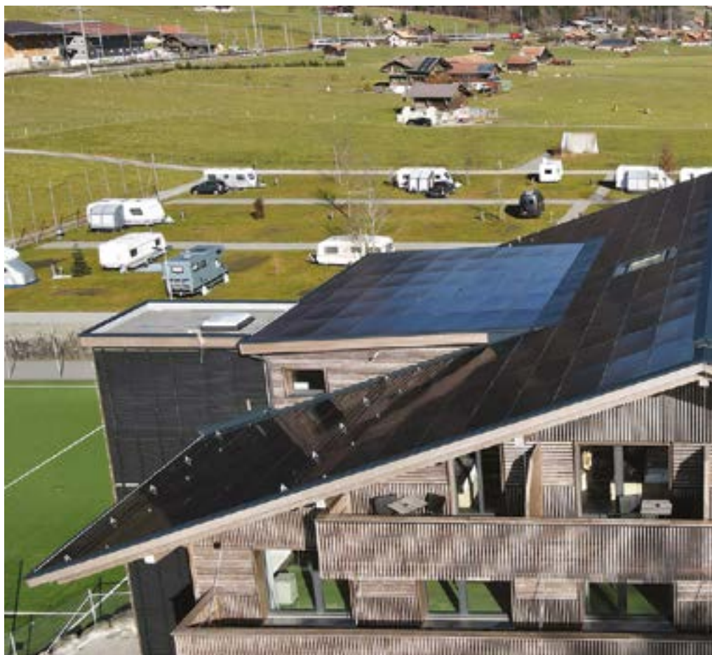
▲ © MEGASOL ENERGIE AG
